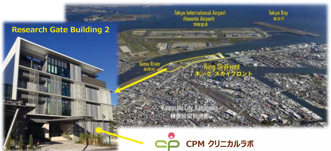
神奈川県川崎市川崎区殿町：殿町国際戦略拠点キングスカイフロント内
